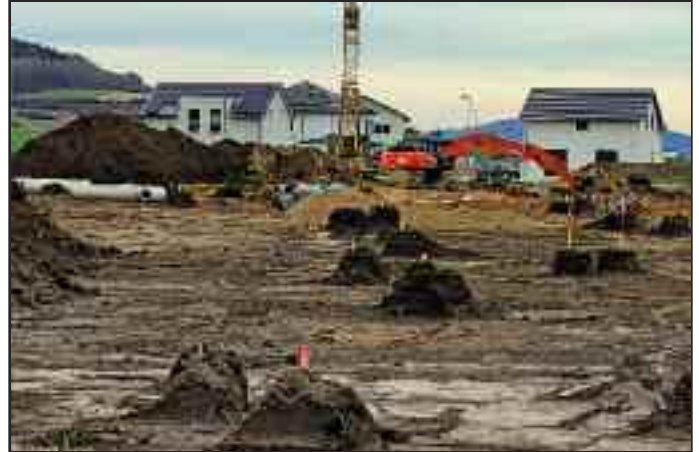
Nach dem Abschieben des Oberbodens, begannen die Vorbereitungen zum Straßenbau.
