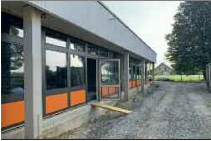
Im Zuge des Einbaus der neuen Fassadenelemente erhält zukünftig jedes Klassenzimmer einen direkten Zugang ins Freie.
