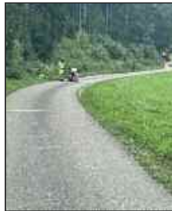
Mit schwerem Gerät musste der Asphaltbelag auf Teilflächen eines Feldwegs im Gewann „Winkelfeld“ in Friedingen entfernt werden.
