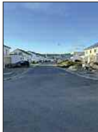
Der neu eingebaute Asphaltbelag in der „Montfortstraße“ im Baugebiet „Stucken“.
