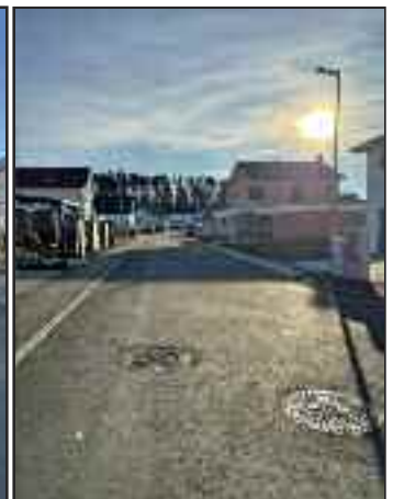
Nachdem mittlerweile bis auf einen Bauplatz alle Grundstücke, zumindest mit dem Rohbau, bebaut sind, erfolgte die Straßenfertigstellung auch in der „Karl-Friedrich-Straße“ im Baugebiet „Stucken“.
