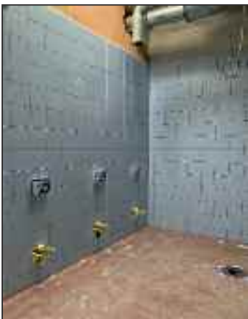
Nach dem Einbau der Trennwand erfolgten die Fliesenarbeiten im Bereich der WC's.
