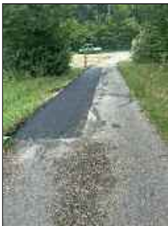
Im Bereich der Zufahrt zum Hochbehälter Wilflingen, musste vor der Asphaltierung auch der Unterbau ertüchtigt werden.
