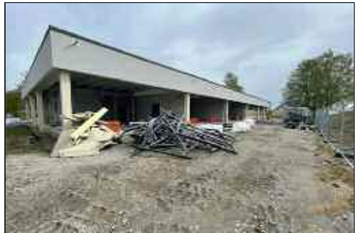
Beim Ausbau der bestehenden Fassadenelemente mussten die Materialien sorgfältig sortiert werden.
