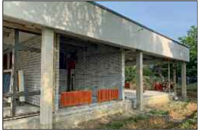
In mehreren Abschnitten wurde die alte Fassade ausgebaut und die neuen Holz-Alu-Elemente eingebaut.
