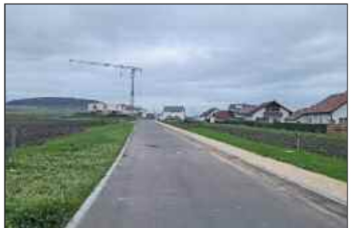
Mit dem Einbau der Asphalttragschicht und der Aufschotterung der Gehwege wurden die Erschließungsarbeiten beendet.
