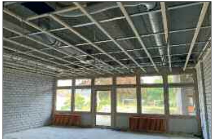
Nach Einbau der Holz-Alu-Fassaden nahm auch der Innenausbau Gestalt an.
