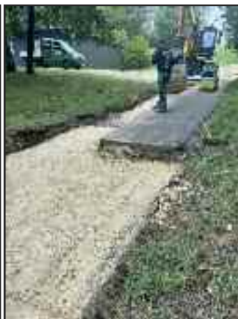
Unterhalb des Schützenhauses Wilflingen musste der Unterbau des Weges verstärkt werden.
