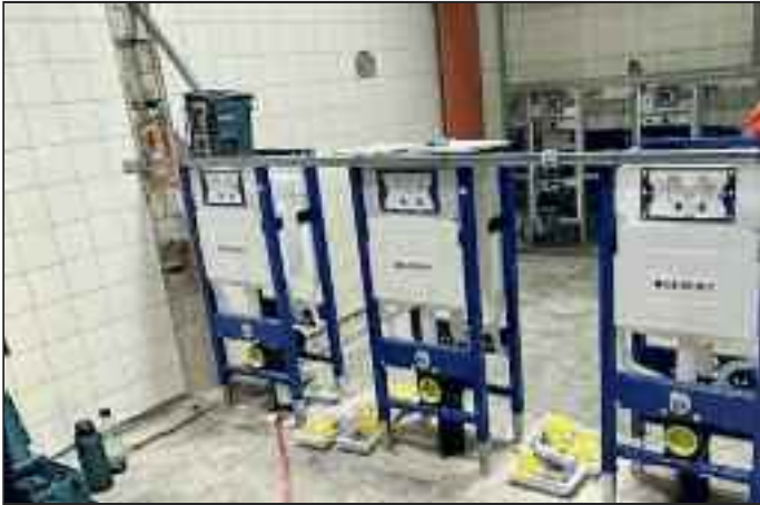
Nach dem Rückbau des kompletten WC-Traktes erfolgte der Einbau der neuen Spülkästen.
