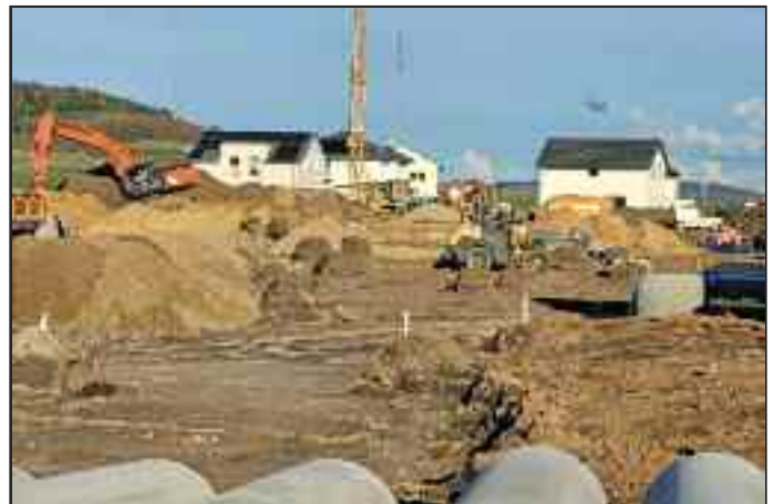
Die notwendigen Rohre für die Schmutz- und Regenwasserkanalisation wurden zur Verlegung vorbereitet.
