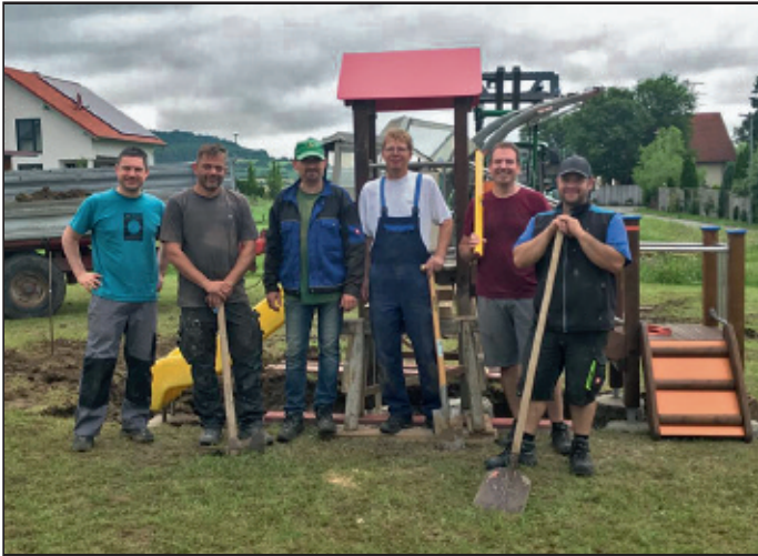
Durch viele fleißige Helfer konnte das Aufstellen der Geräte in Eigenleistung erfolgen – herzlichen Dank
