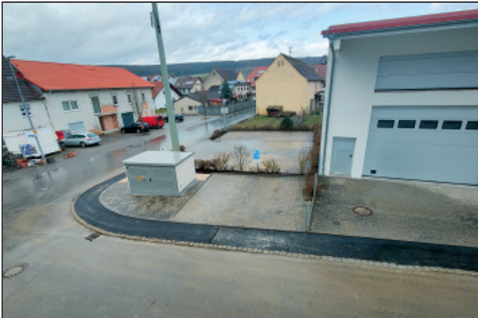
Die neue moderne Trafostation nach ihrer Fertigstellung
