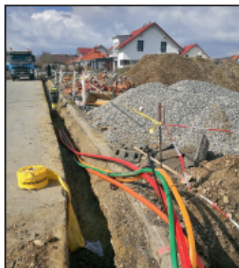
Im Zuge der Neuerschließung erfolgte ein umfangreicher Breitbandausbau
