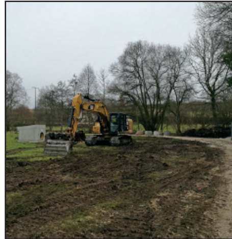
Zum Jahresende wurde die Baustelle durch die Firma Blum eingerichtet
