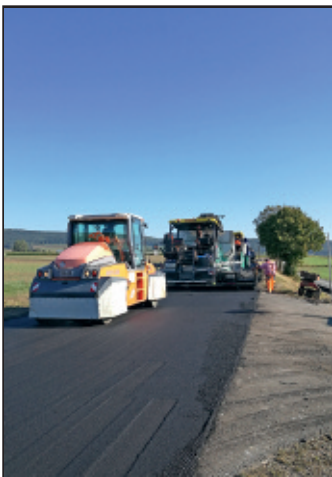
Einbau des neuen Asphaltbelages auf der Landesstraße
