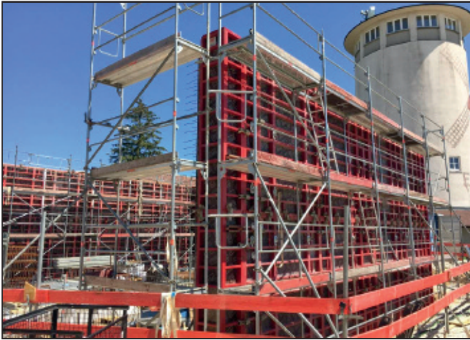
Die Betonarbeiten zur Errichtung des neuen Hochbehälters konnten zügig umgesetzt werden
