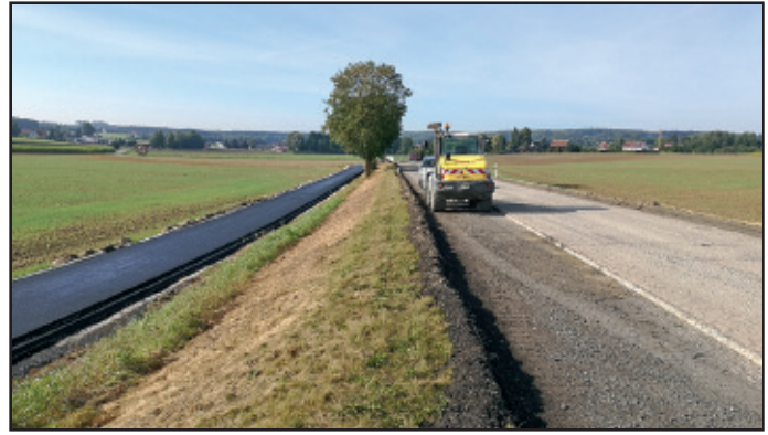
Nach dem Abfräsen des Asphaltbelages auf der L 277 erfolgte der Einbau des Asphaltbelages auf dem Radweg
