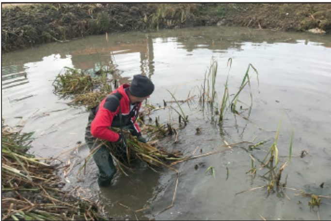
In einzelnen Bereichen war auch noch Handarbeit notwendig (Bild: LEV)
