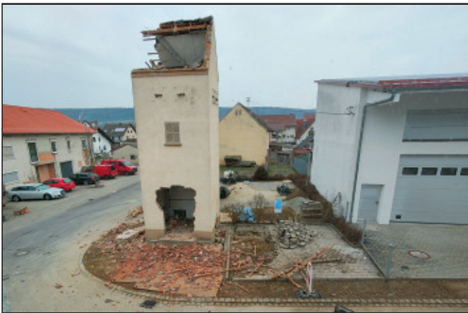
Der einstige Trafoturm musste einer modernen Trafostation weichen
