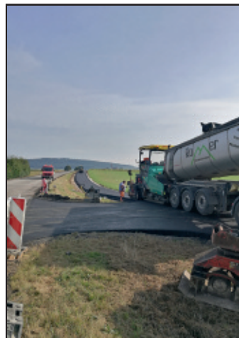
Einbau des Asphaltbelages auf dem neuen Radweg
