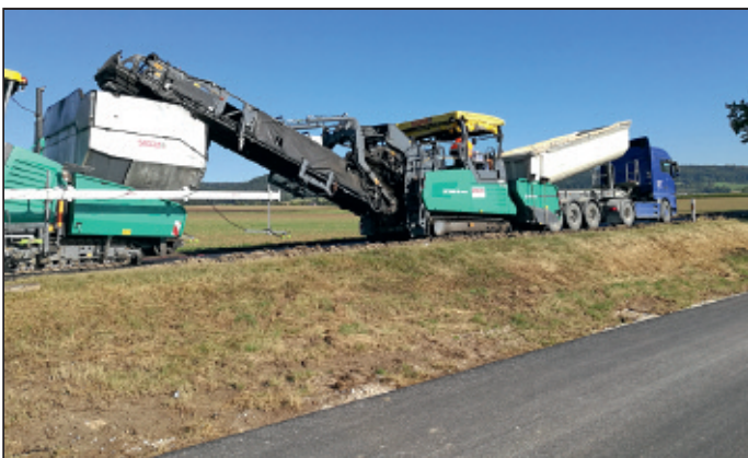
Große Gerätschaften waren zur Umsetzung dieser Maßnahme erforderlich
