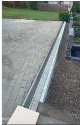
Durch den Einbau der neuen Rinne erfolgte eine deutlich optische Aufwertung
