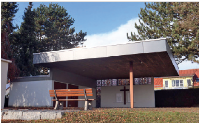
Die neue Dachverwahrung verleiht der Aussegnungshalle in Andelfingen eine deutliche Aufwertung
