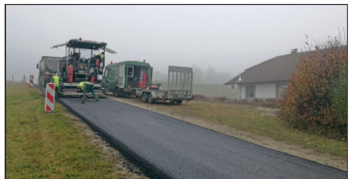
Asphalteinbau beim Tennisheim
