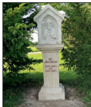
Durch die Sanierung ergab sich eine deutliche optische Aufwertung des Bildstocks
