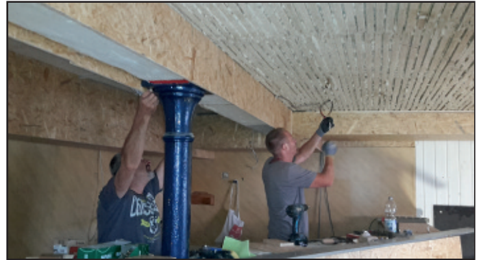
Viele fleißige Hände waren notwendig, um die zahlreichen notwendigen Maßnahmen umzusetzen
