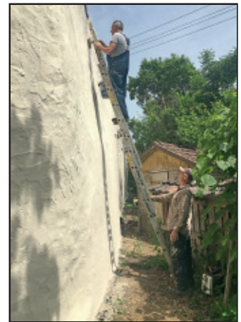
Um der kompletten Friedhofsmauer einen neuen Anstrich zu verpassen, mussten die Helfen bis Weilen hoch hinauf.
