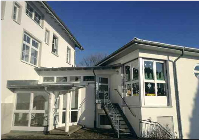
Die frisch sanierte Außenfassade erstrahlt in neuem Glanz.
