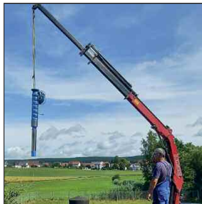
Die neue Förderpumpe wird in den Pumpenschacht eingesetzt.
