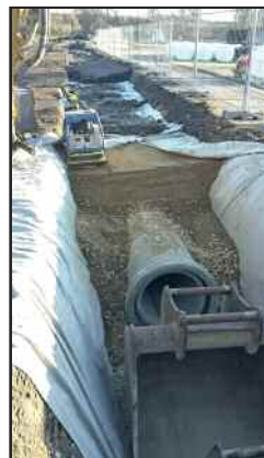
Sorgsam musste der neue Regenwasserkanal in den schwierigen Untergrund eingebettet werden
