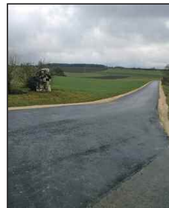
Der neu eingebaute Asphaltbelag auf der Gemeindeverbindungsstraße Billafingen-Wilflingen.
