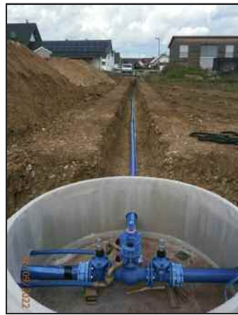
Die neuerlegte Wasserleitungsstrasse samt Schachtbauwerk.
