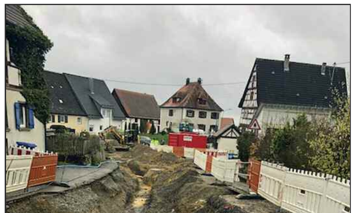
Nachdem der Mischwasserkanal verlegt war, wurde alles für die Verlegung der neuen Wasserleitung vorbereitet.
