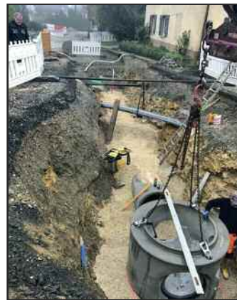
Ein neues Schachtbauwerk wird an den neuen Mischwasserkanal angepasst.
