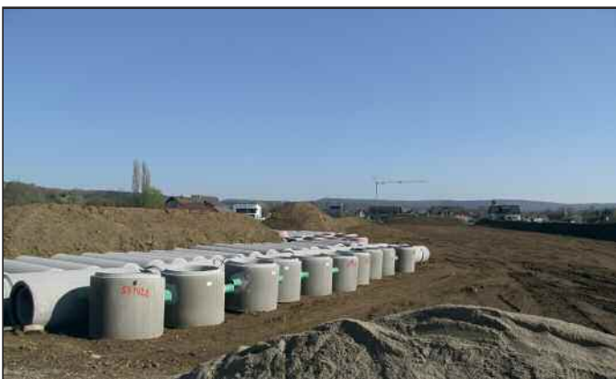
Auch das Material im Baugebiet „Herdwegäcker“ lag zu Beginn der Tiefbaumaßnahmen bereit.
