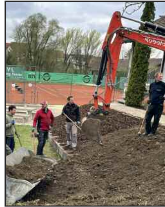
Pflege der Anlage – Neugestaltung der Böschung um den Grillplatz
