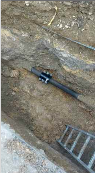
Ein Wasserrohrbruch im Ortsteil Andelfingen wurde fachmännisch repariert.
