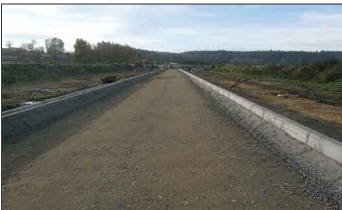
Nach dem Setzen der Bordsteine war der Straßenverlauf gut erkennbar.
