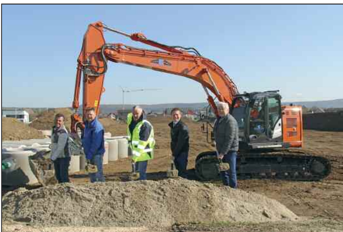
Spatenstich zur Erweiterung des Baugebiets „Herdwegäcker“ im Ortsteil Wilflingen, v.l. Klaus Vogel, Ingenieurbüro Schwörer Altheim, Stefan Meinhold, Ortsbaumeister, Andreas Mayer, Fa. Eberhard, Bürgermeister Andreas Schneider, Ortsvorsteher Werner Späth.
