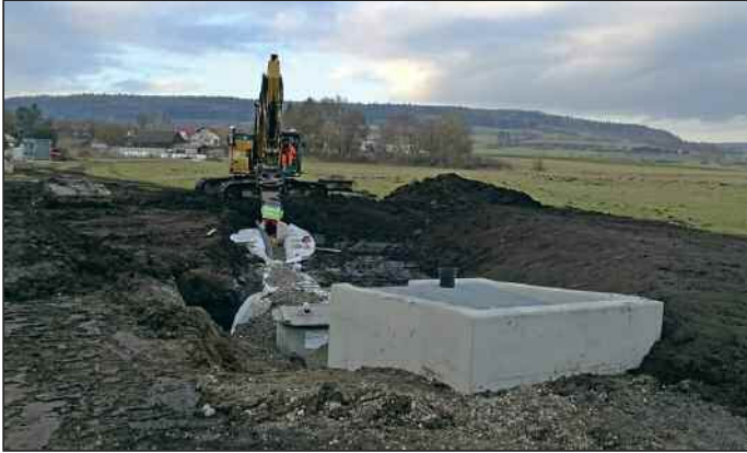
Das neue Retentionsbecken mit dem erforderlichen Drosselschacht nimmt Form an.
