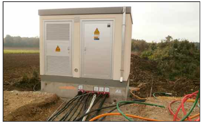
Ausgehend von der neuen Trafostation erfolgten umfangreiche Kabelarbeiten.
