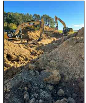
An mehreren Stellen wurde gleichzeitig gearbeitet.
