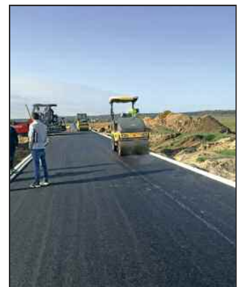
Einbau des neuen Asphaltbelags im Straßenbereich.
