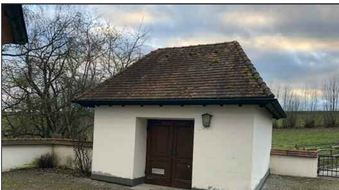
Die Abdichtung des Außenmauerwerkes ist abgeschlossen. Ein neuer Anstrich des Außenmauerwerkes steht noch aus.
