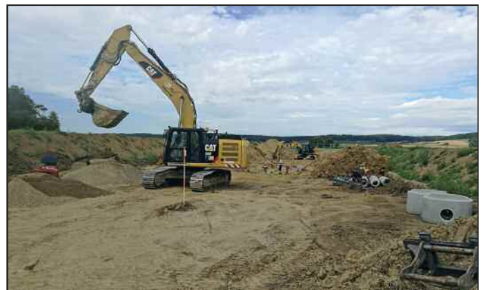
Im Rahmen der Erschließungsarbeiten waren große Erdbewegungen und schweres Gerät notwendig.
