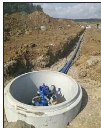
Einbau der Wasserleitungen inkl. der erforderlichen Hausanschlussleitungen.
