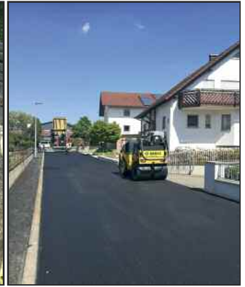
Abschließend erfolgte der Einbau eines komplett neuen Asphaltbelages
