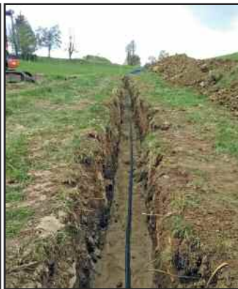
Die Verlegung einer komplett neuen Zuleitung war notwendig
