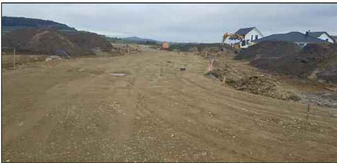
Der neue Straßenverlauf ist bereits erkennbar
