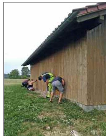
Viele Hände unterstützten die Anbringung des neuen Farbanstriches
