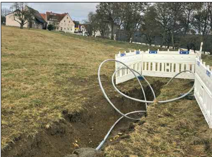
Anbindung der neuen Leerrohre an die bestehende Breitbandtrasse
