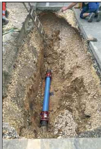
Das neu eingebaute Leitungsstück an der Hauptwasserleitung im Heerweg im Ortsteil Emerfeld
