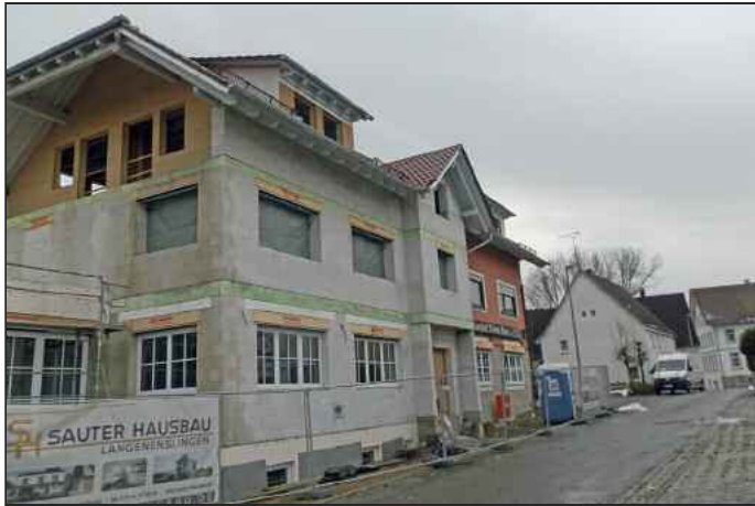
Bereits zum Jahresende waren die Dimensionen des Neubaus deutlich erkennbar
