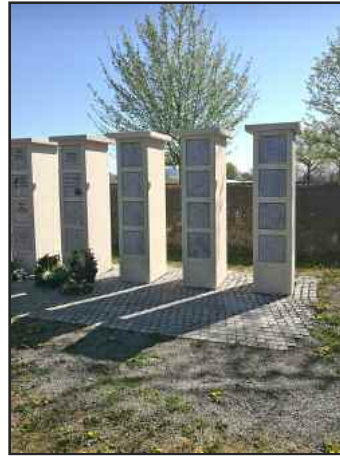
Ergänzung der Urnenstelenanlage auf dem Friedhof Langenenslingen
