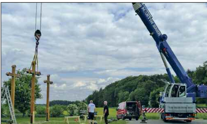
Zum Aufstellen der neuen Kreuze war schweres Gerät erforderlich
