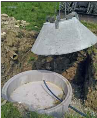
Ein neues Schachtbauwerk zur besseren Fassung des Quellwassers wurde eingebaut
