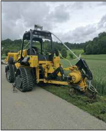
Schweres Gerät war zum Einpflegen der Breitbandleerrohre notwendig
