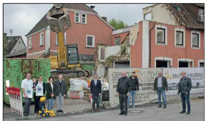
Nach Bewilligung der Fördermittel wurde im Frühjahr mit den Abbrucharbeiten begonnen
