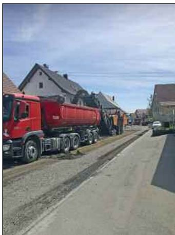
Im Bereich der Ortsdurchfahrt Billafingen wurde der schadhafte Asphaltbelag komplett abgefräst
