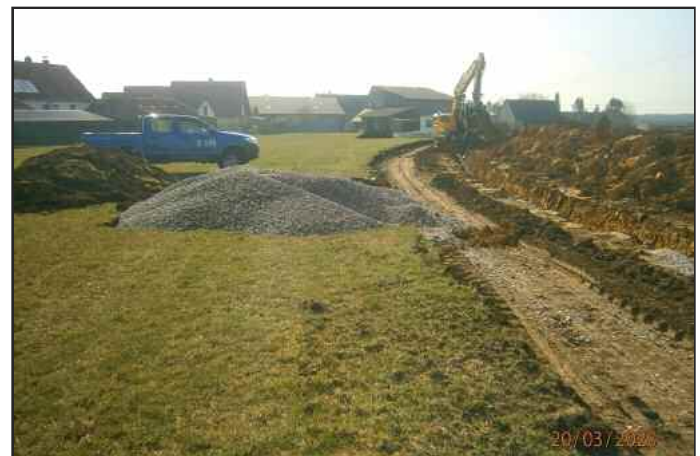
Umfangreiche Erdarbeiten im Zusammenhang mit dem Austausch der Hauptwasserleitung im Ortsteil Billafingen waren notwendig
