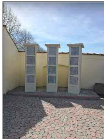
Auch im Friedhof Wilflingen wurden an einem neuen Standort drei weitere Urnenstelen aufgestellt
