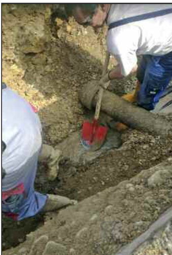
Aufgrund anderweitiger Leitungen ist oft Handarbeit notwendig
