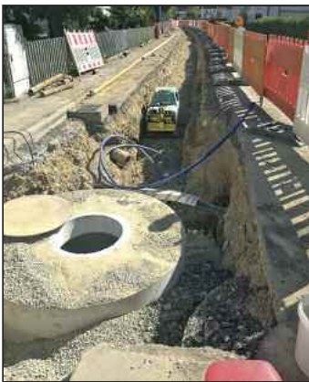
Innerhalb der neuen Leitungstrasse war auch der Einbau neuer Schachtbauwerke erforderlich
