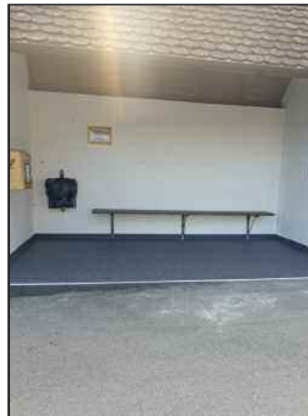
Der neu eingebaute Bodenbelag wertet die Bushaltestelle deutlich auf
