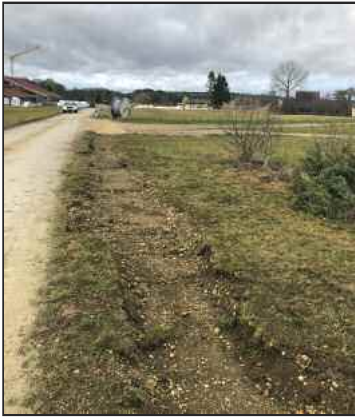
Die Breitbandtrasse führt entlang eines Feldweges in Richtung Ittenhausen
