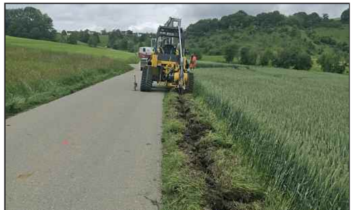
Im Bereich Warmtal wurden die Breitbandleerrohre mittels Pflugverfahren verlegt
