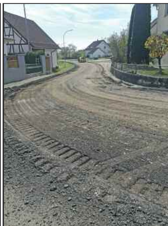
Im Kurvenbereich der Ortsdurchfahrt Emerfeld wurde der Asphaltbelag ebenfalls komplett ausgetauscht
