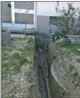
Sobald von den Hauseigentümern gewünscht, wurden neue Wasserhausanschlüsse sowie ein zusätzlich kombinierter Gas- und Breitbandhausanschluss mitverlegt
