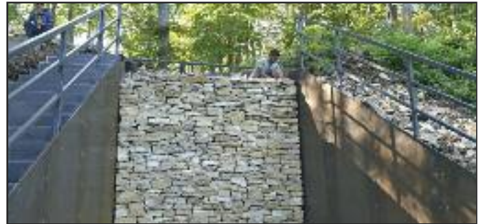
Letzte Handgriffe zur Fertigstellung des historischen Mauerabschnitts
