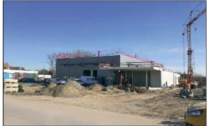
Erschwerte Bedingungen im Rahmen der Erschließung, da parallel hierzu die neue Produktionshalle der Firma ensutec fertig gestellt wurde
