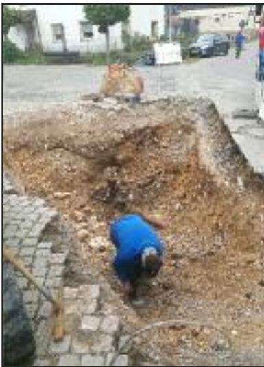
Vorbereitete Tätigkeiten zum Einbau eines neuen Schachbauwerkes im Bereich Inneringer Straße / Angerstraße
