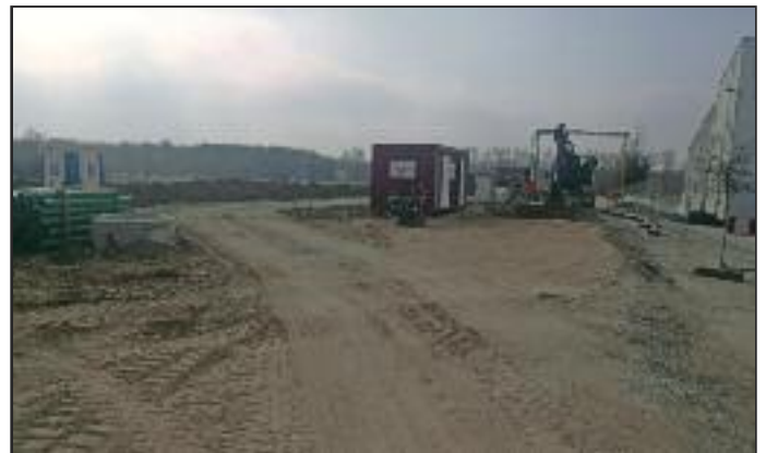
Mehrmals mussten provisorische Baustraßen eingerichtet werden
