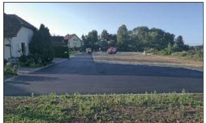
Nach Fertigstellung wurde im kompletten Erschließungsbereich ein neuer Asphaltbelag
