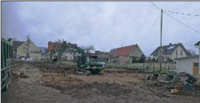
Nach Abbruch der Gebäude entstand ein großzügiges Gelände
