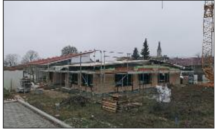
Kurz vor Weihnachten konnte das Dach noch geschlossen werden
