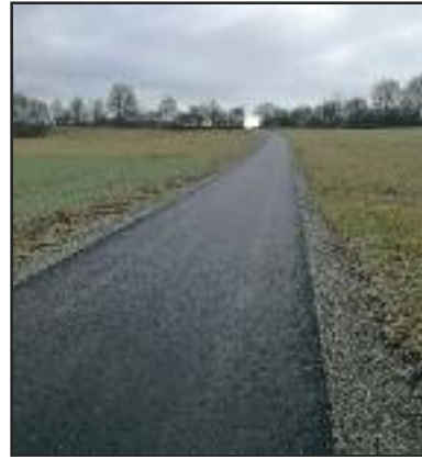
Anschließend erfolgte der Einbau des Asphaltbelags auf dem gesamten Teilabschnitt
