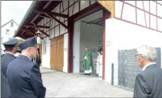
Das umgebaute und erweiterte Feuerwehrgerätehaus erstrahlt in neuem Glanz
