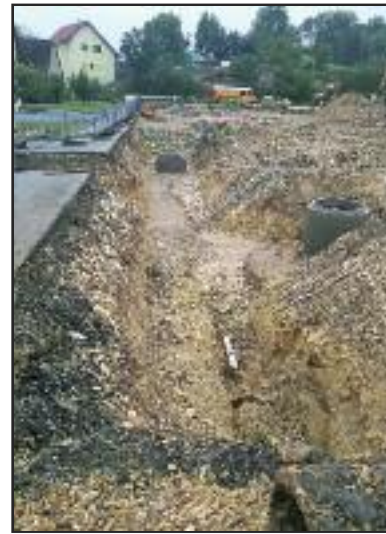
Die Erschließungs- und Straßenbauarbeiten sind in vollem Gange
