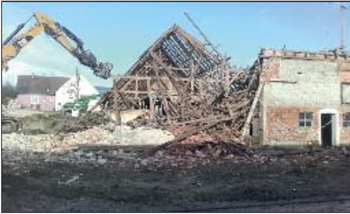
Die Abbrucharbeiten sind in vollem Gange
