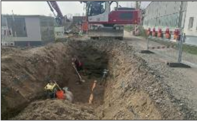
Verlegung der neuen Schmutzwasser- und Regenwasserkanäle
