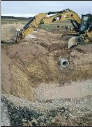
Mehrere Bagger waren gleichzeitig bei der Verlegung der umfangreichen Regenwasserkanalisation im Einsatz
