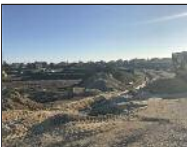
Gigantische Erdbewegungen waren im Zuge der Erschließungsarbeiten notwendig
