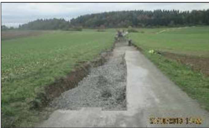
Auch am Unterbau waren umfangreiche Sanierungsmaßnahmen erforderlich
