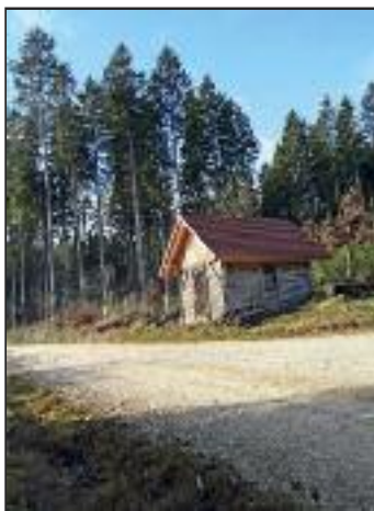
Nach erfolgter Dachsanierung erstrahlt die Waldhütte wieder in neuem Glanz
