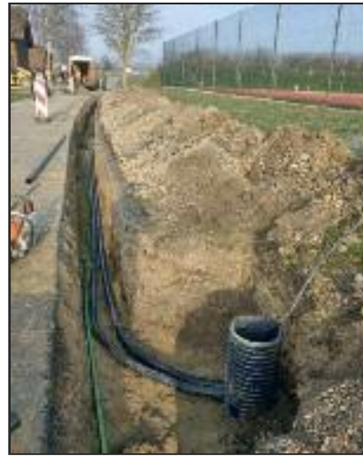
Verlegung der Leerrohre und Einbau der Fundamente im Bereich der Tennisanlage
