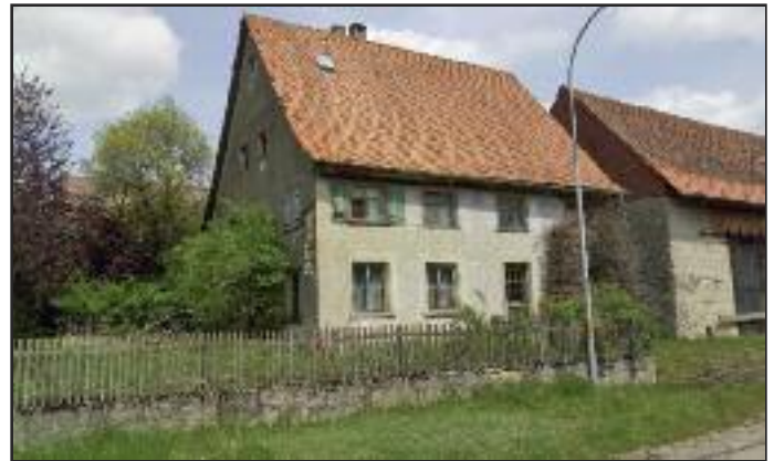
Das Wohngebäude Habsbergerstraße 1 vor dem Abbruch
