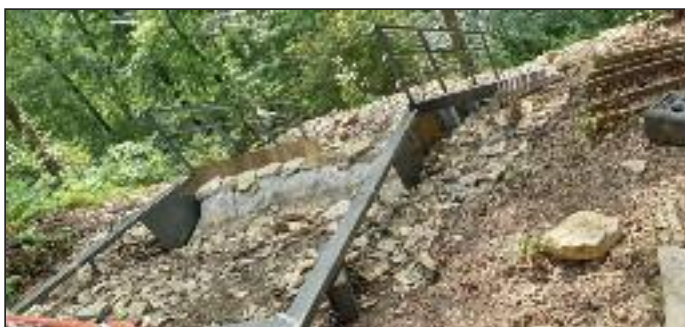
Einbau der Metallkonstruktion zur Absturzsicherung inklusive Treppenanlage
