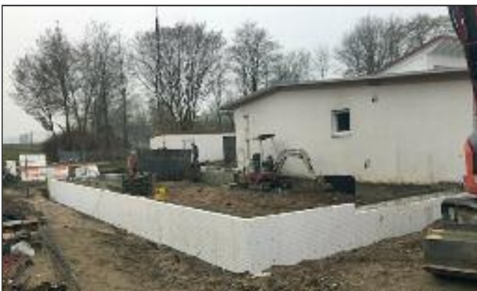
Fundamentarbeiten beim Neubau der Kinderkrippe
