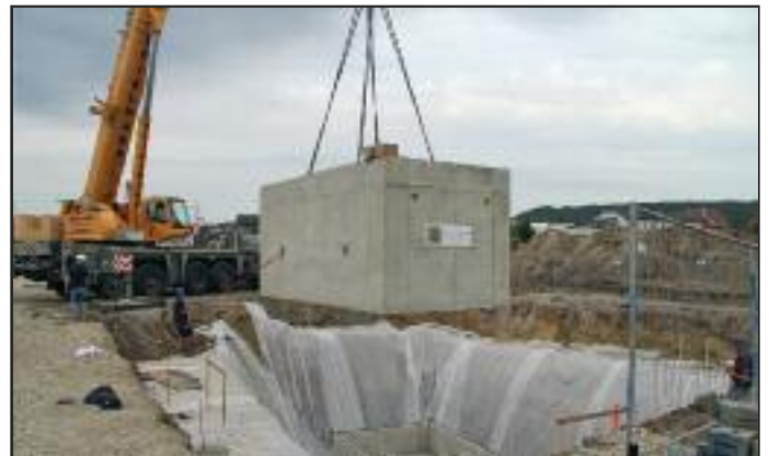
Mit schwerem Gerät erfolgte der Einbau des zentralen Schmutzwasserpumpwerks
