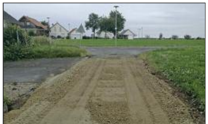
Sanierter Unterbau an einem Teilstück des Eichertwegs
