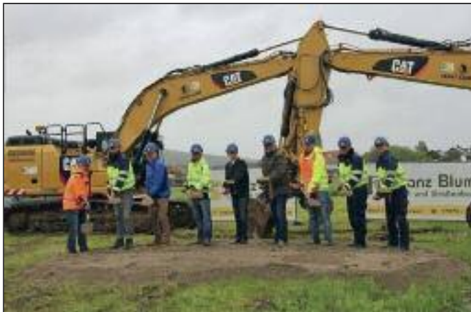
Offizieller Spatenstich zur Erschließung des Neubaugebiets „Stucken“
