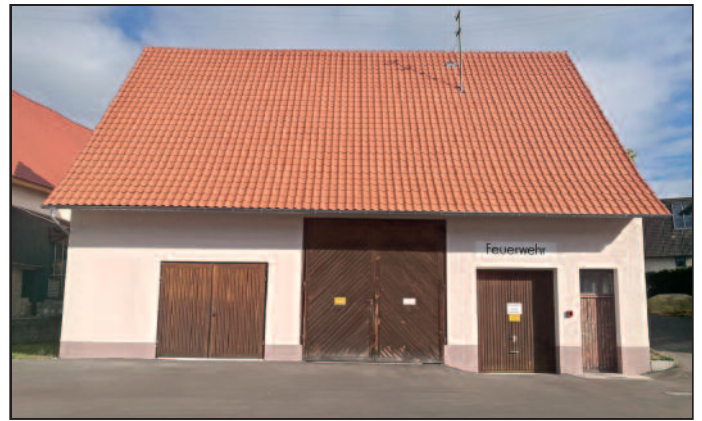
Erneuerter Außenputz am Feuerwehrgebäude im Ortsteil Billafingen
