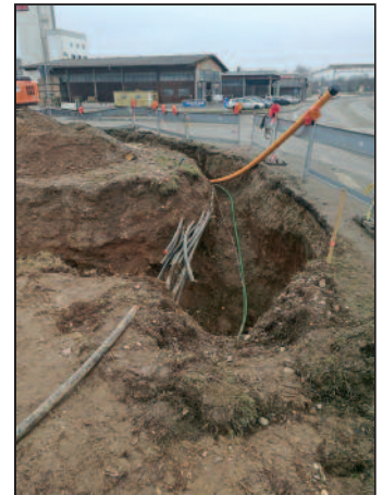
Auch im neuen Gewerbegebiet „Altheimer Straße“ wurden bereits Leerrohre zur Breitbanderschließung verlegt.
