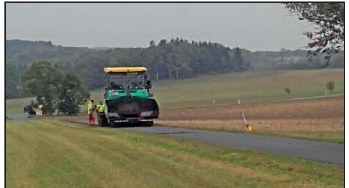
Asphalteinbau auf der Gemeindeverbindungsstraße im Gewann „Anger“ im Ortsteil Emerfeld
