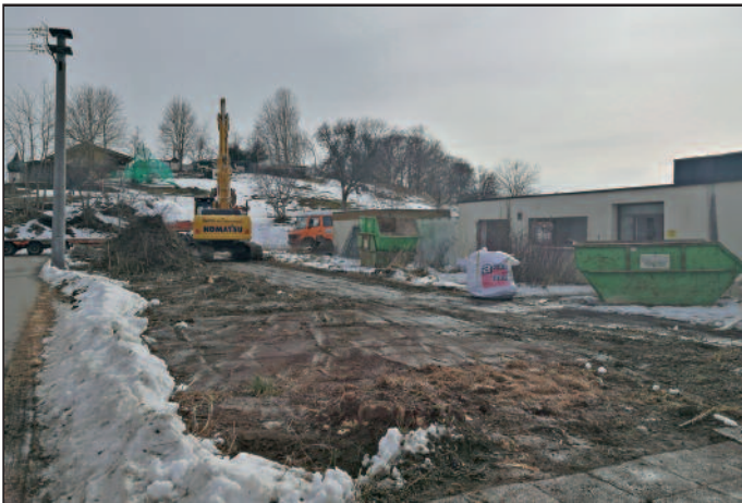
Beginn der Abbrucharbeiten durch die Fa. Späth
