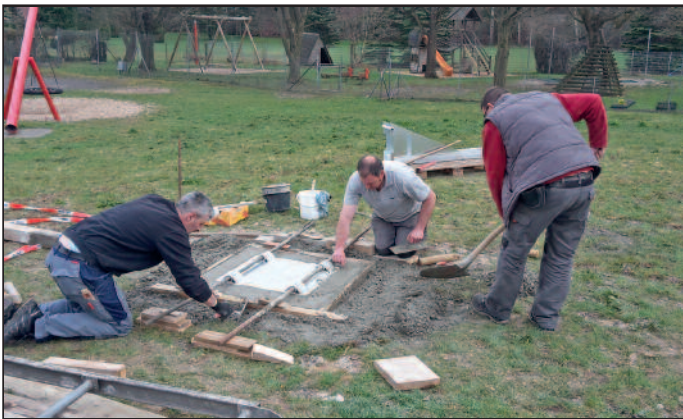
Fachgerechter Einbau des Maibaumfundaments
