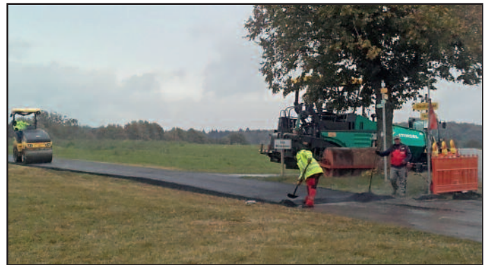
Asphaltarbeiten auf der Gemeindeverbindungsstraße von Emerfeld nach Ittenhausen
