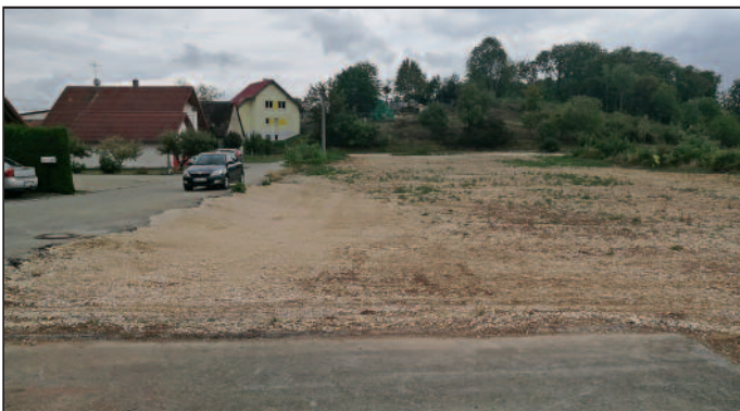
Nach Abbruch der Gebäude ist ein großzügiges Gelände entstanden
