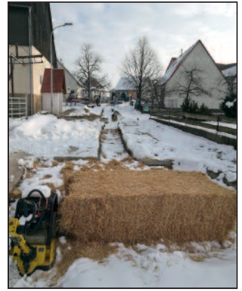
Frostsicherung der neuen Wasserleitung mit Hilfe von Strohballen
