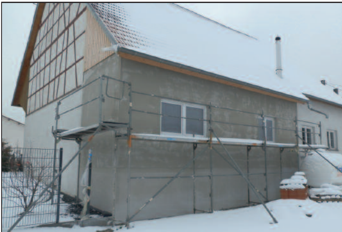
Neu aufgetragener Außenputz am Feuerwehrgebäude Ittenhausen
