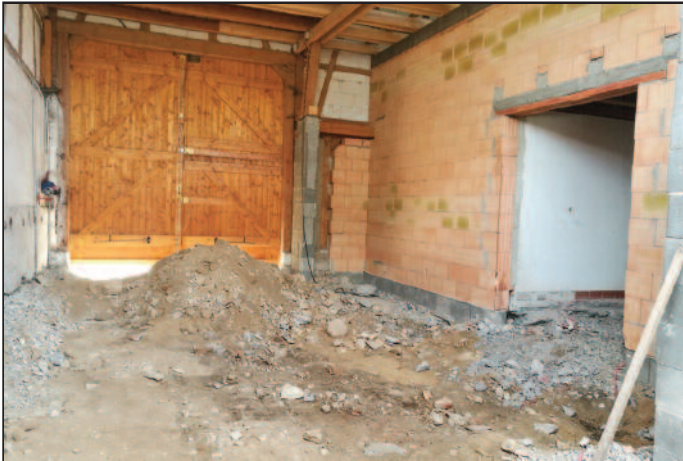
Der komplette Boden der zukünftigen Fahrzeughalle wurde entfernt
