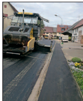
Einbau der Asphaltdeckschicht in der Enhofer Straße
