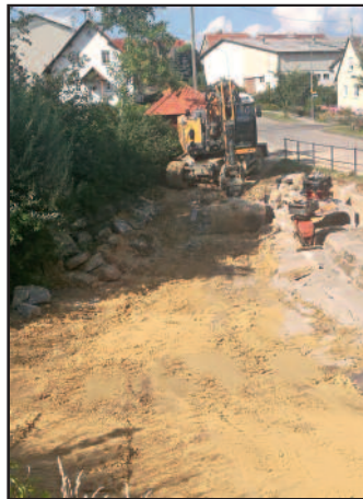
Umfangreiche Baggerarbeiten zur Abdichtung der Hülbe war notwendig
