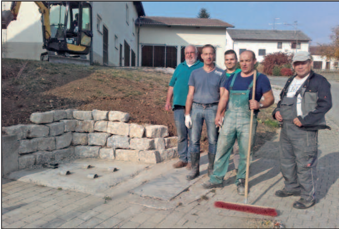
Die fleißigen Helfer neben der neu errichteten Stützmauer
