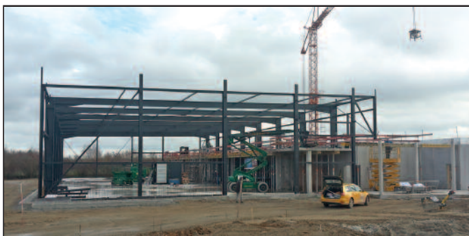
In Rekordzeit stand das Stahlgerüst der neuen Produktionshalle
