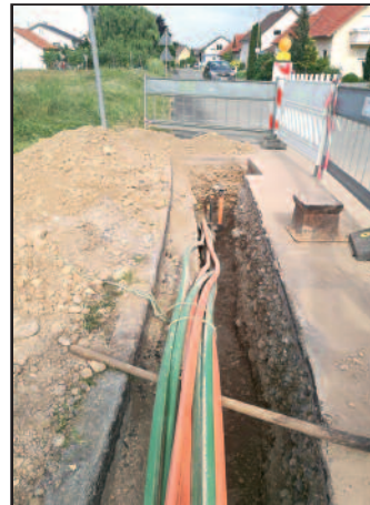
Zum Teil wurden größere Bündel an Leerrohren verlegt.
