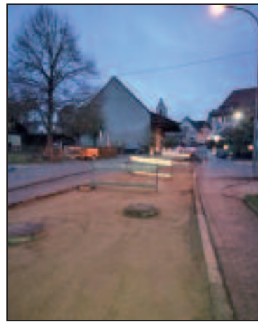
Stauffenbergstraße vor dem Einbau der Asphalttragschicht.
