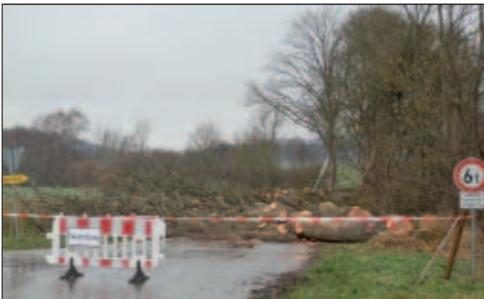
Die gefällten Eschen liegen auf der Straße und werden anschließend mittels Rückefahrzeugen aufgeräumt.
