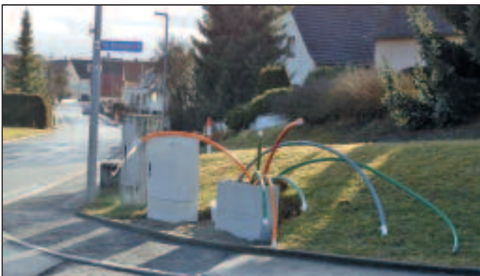
Die verlegten Leerrohre in den neuen Kabelverzweigern.
