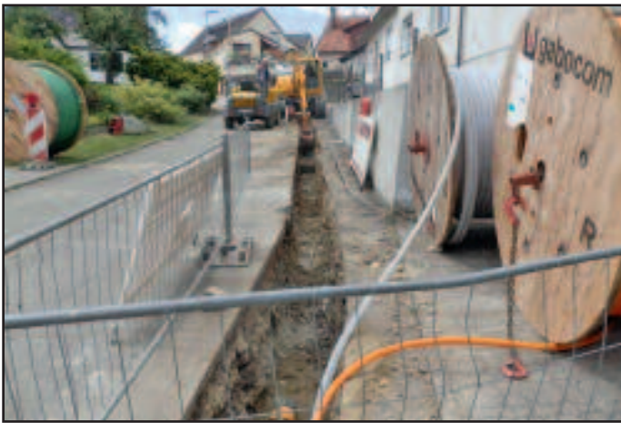
Gasausbau in der „Bischof-Helding-Straße“ im Ortsteil Langenenslingen
