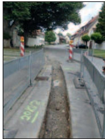
Gasausbau in der „Stauffenbergstraße“
