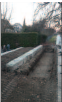
Tiefbauarbeiten für die neuen Urnenstelen beim Friedhof Andelfingen
