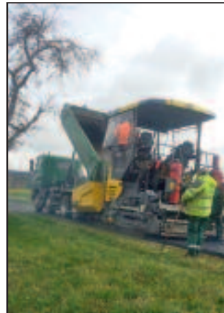
Asphaltparbeiten an der Gemeindeverbindungsstraße Friedingen Richtung Emerfeld
