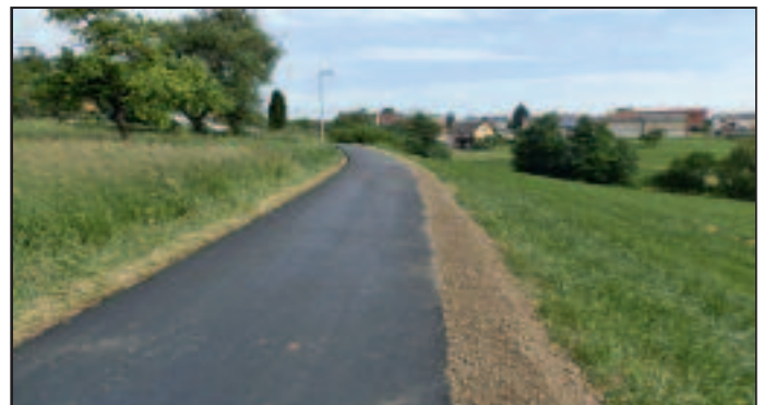
Der neu asphaltierte Kirchenweg im Ortsteil Emerfeld.
