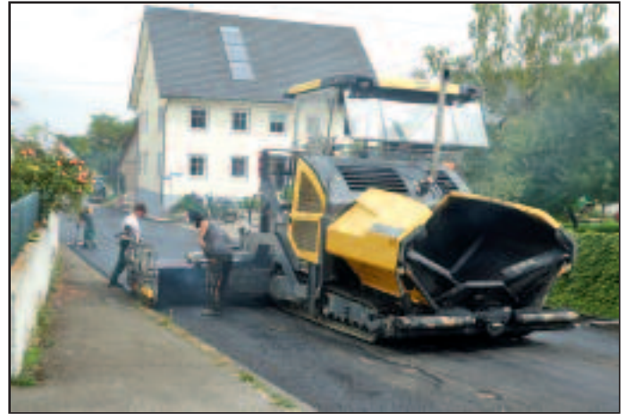
Asphalteinbau auf einem Teilstück des „Schwebewegs“ im Ortsteil Dürrenwaldstetten.
