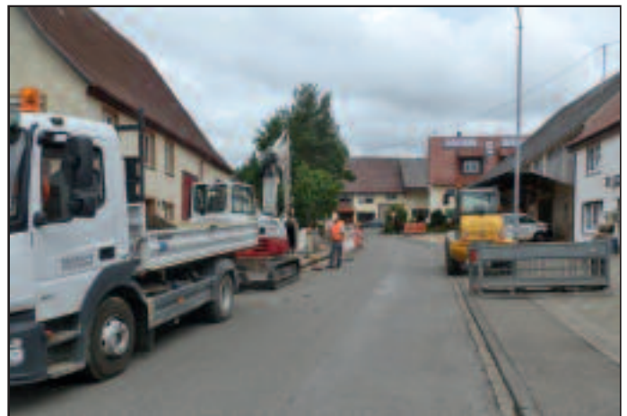
Gasausbau in der „Enhofer Straße“ im Ortsteil Wilflingen
