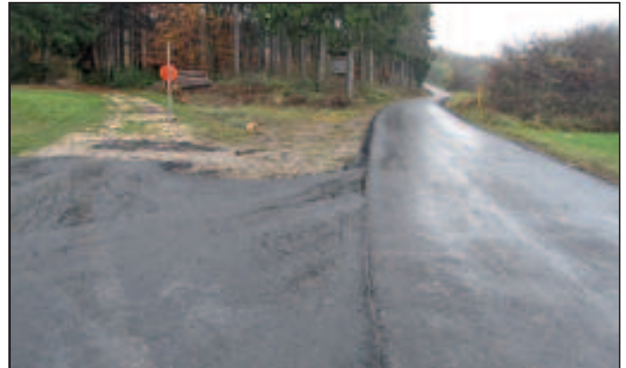
Neuasphaltiertes Teilstück des Feldweges „Krummer Berg“ im Ortsteil Andelfingen
