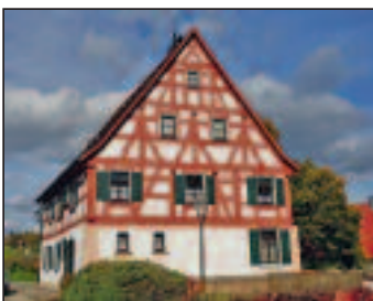
Die Renovierungsarbeiten am Pfarrhaus Emerfeld sind nun abgeschlossen
