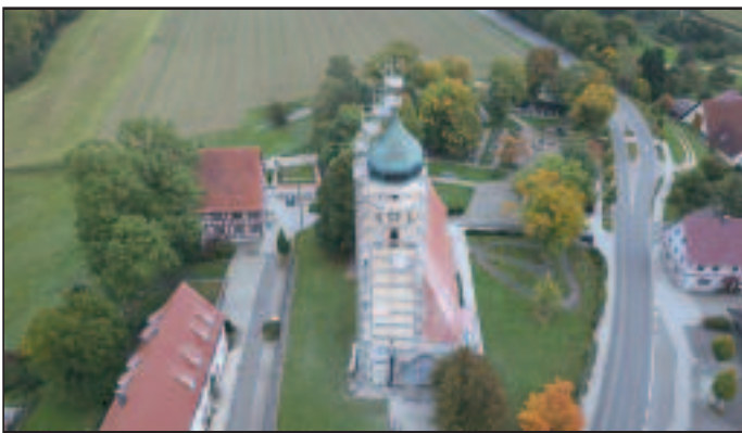
Imposantes Gerüst an der Mauritius Kirche im Ortsteil Langenenslingen
