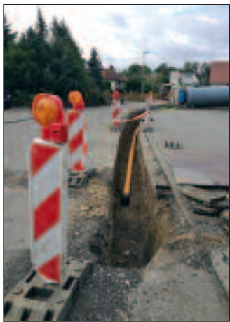
Gasausbau in der „Schattenweiler Straße“ im Ortsteil Langenenslingen
