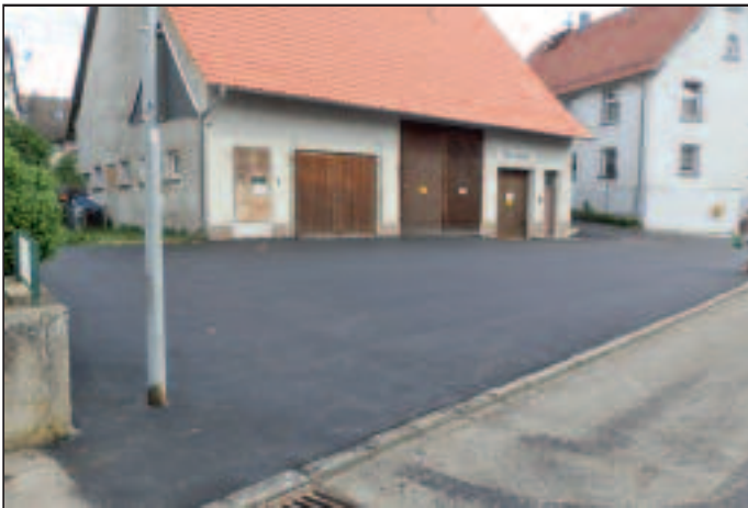
Neuasphaltierter Hofraum beim Feuerwehrgerätehaus im Ortsteil Billafingen.
