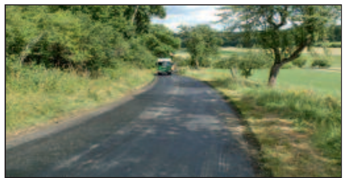
Asphalteinbau auf der Gemeindeverbindungsstraße von Egelfingen nach Bingen
