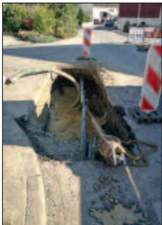
Spülbohrung im Bereich der „Langwatte“ in der „Schattenweiler Straße“
