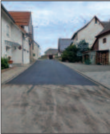
Teilweiser Neueinbau einer Asphalttschicht in der „Brunnenstraße“ im Ortsteil Billafingen.
