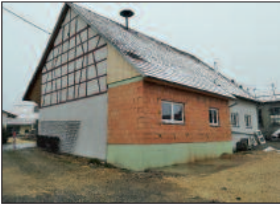
Anbau des Feuerwehrgerätehauses im Ortsteil Ittenhausen
