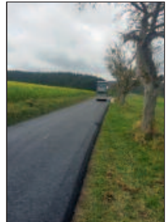
Neueingebauter Asphaltbelag auf der Gemeindeverbindungsstraße Friedingen – Emerfeld
