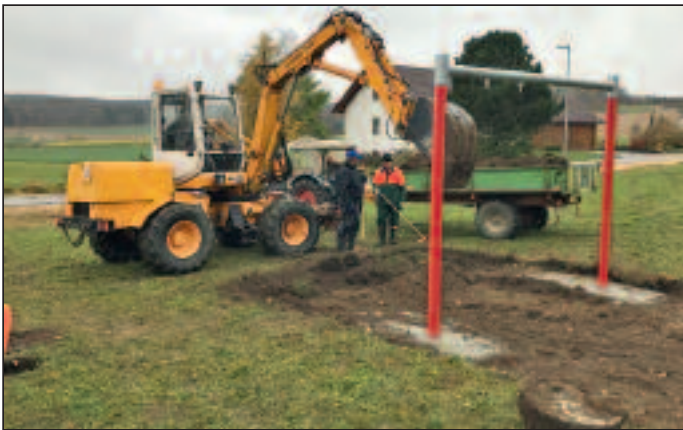
Aufbau der Spielgeräte am neuen Spielplatz in Ortsteil Dürrenwaldstetten.
