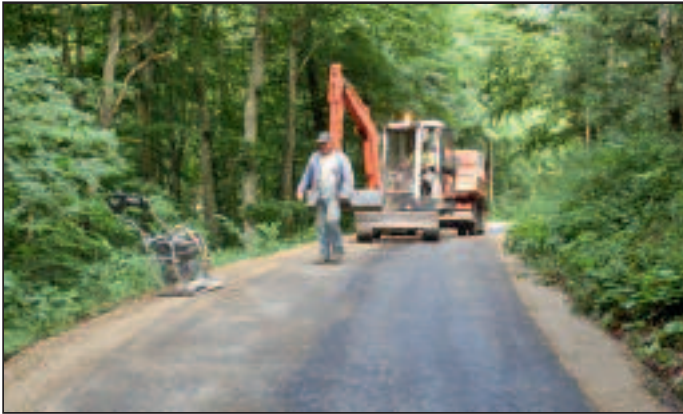
Teilweise Neuasphaltierung der Zufahrt nach Ensmad.
