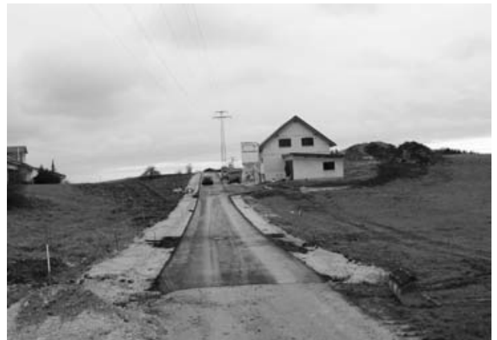
Nun ist auch der Straßenbelag eingebaut für das Baugebiet „Brühl“
