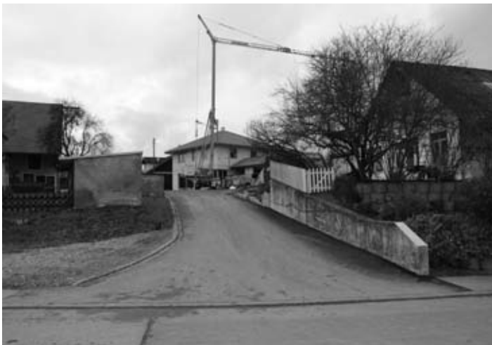
Die neue Zufahrt zum Bauplatz hinter dem Rathaus in Wilflingen.
