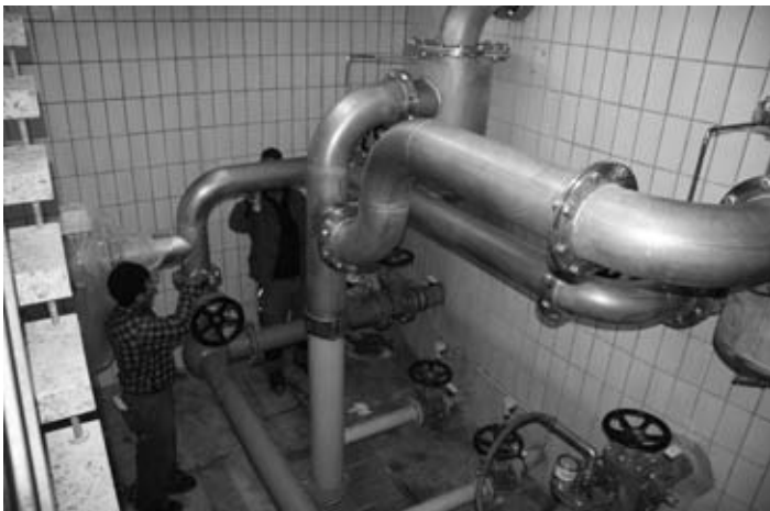
Blick in den umgebauten Rohrkeller im Hochbehälter Wilflingen.
