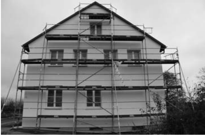
Die „alte Schule“ in Billafingen jetzt mit Gemeindesaal erhielt auf der Westseite eine Isolierung der Außenwand.
