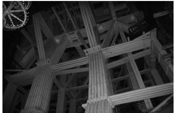
Die Tragkonstruktion aus „versalzenen“ Baumstämmen, die die sehr hohen Räume tragen.
