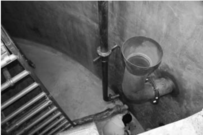
Die neue Überlaufsicung im Hochbehälter Wilflingen.
