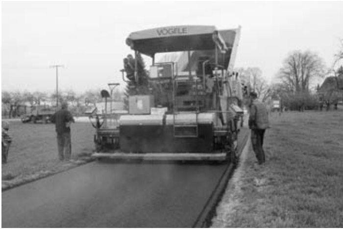
Gerade wird der Belag an der Gemeindeverbindungsstraße Wilflingen-Billafingen eingebaut.
