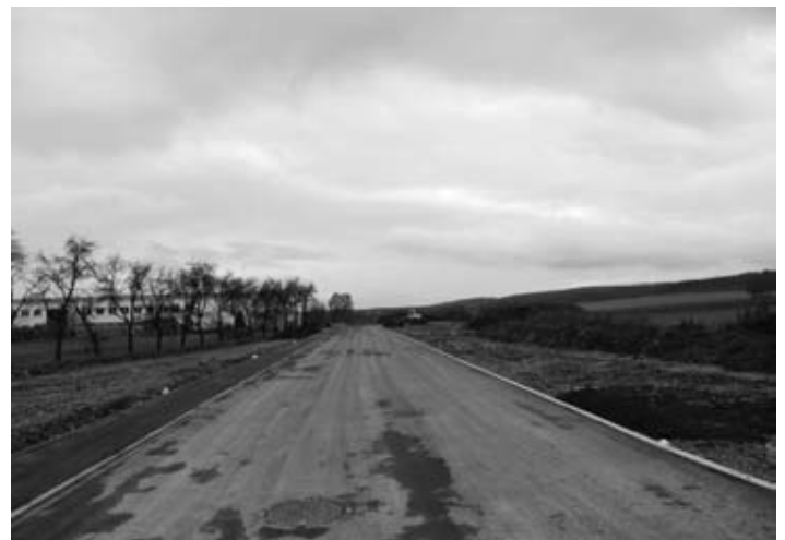
Noch fehlt die Angleichung nach außen bei der neuen Erschließungsstraße im Gewerbegebiet „Esple“ in Langenenslingen.
