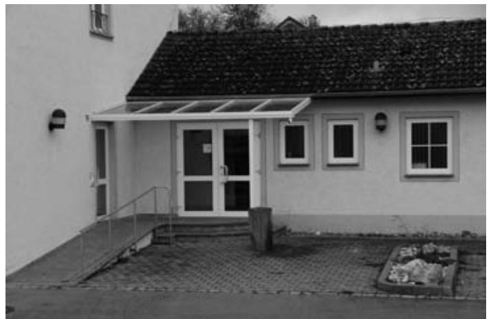
Den Eingangsbereich zum Gemeindesaal Billafingen schützt nun ein Vordach.
