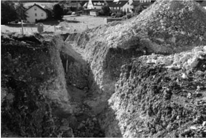
Die Erweiterung des Baugebiets „Brühl“ in Dürrenwaldstetten war nur mit schwerem Meißelgerät möglich.
