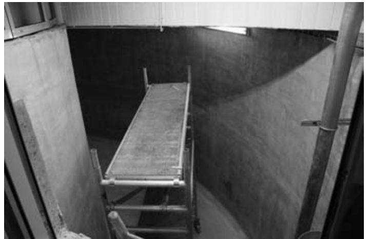
Blick auf die sanierte äußere Kammer im Hochbehälter Wilflingen.
