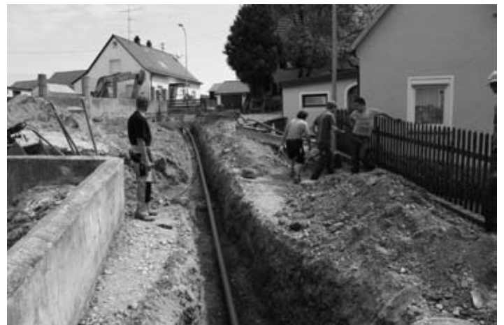
Verlegung der neuen Wasserleitung für den „Boxberg“ in Andelfingen.
