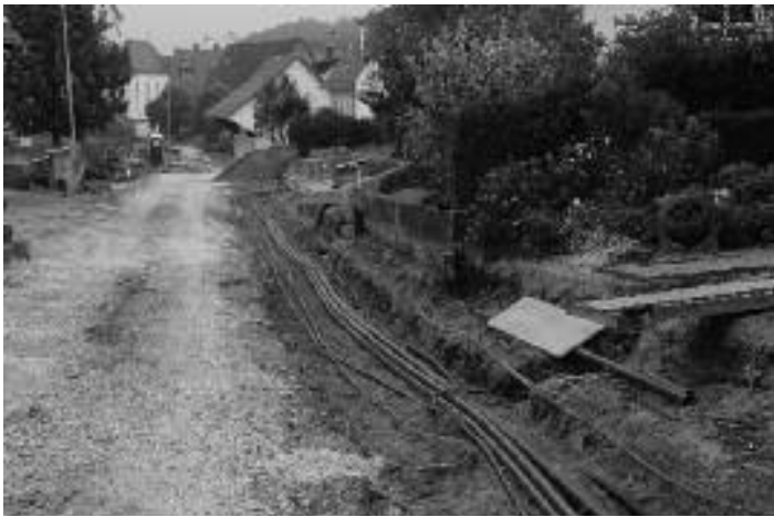
Viele Rohre und Leerrohre wurde in die „Bitzstraße“ in Friedingen eingelegt
