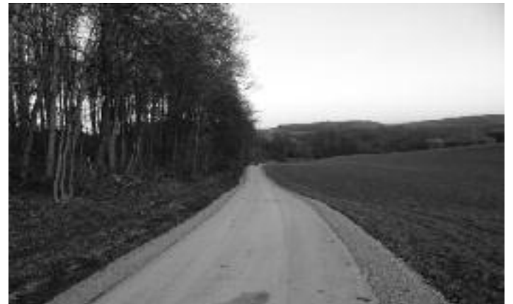
Der neu bituminös befestigte Weg „In der Au“ in Dürrenwaldstetten
