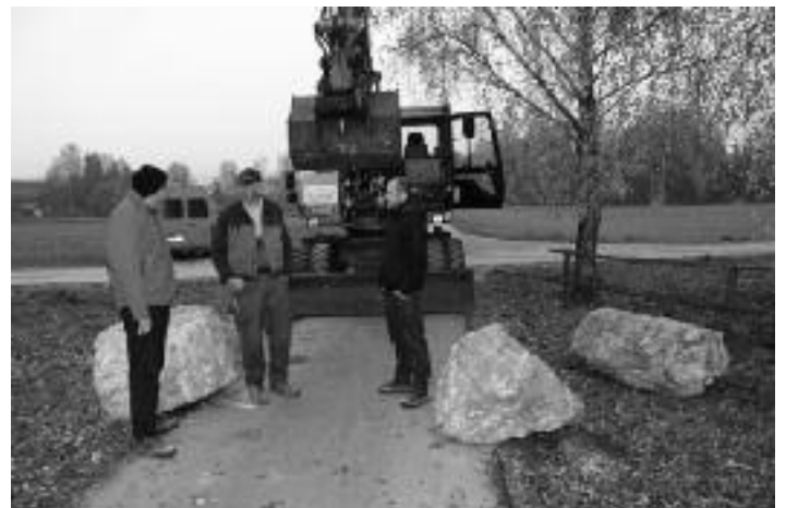
Im Flurbereinungsverfahren Willflingen werden Steinblöcke zur Einengung eines Geh- und Radweges angebracht
