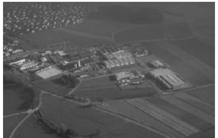
Die technischen Planungen, den Grunderwerb und den Bebauungsplan für unser Gewerbegebiet Esple konnten wir 2013 fertigstellen für die Erweiterung 2014
