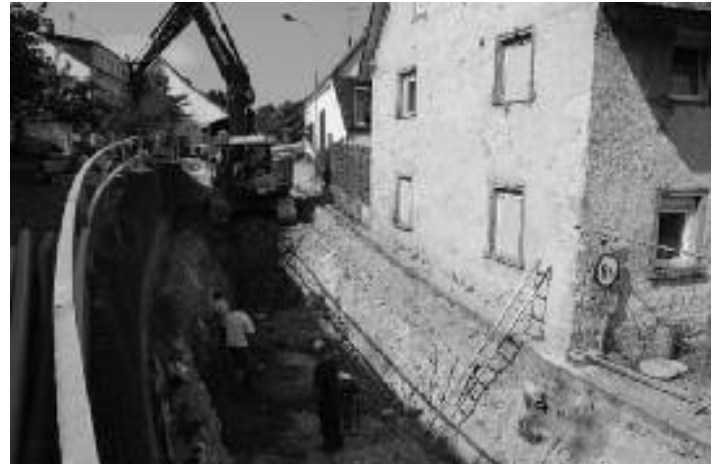
Erneuerung der Kanalisation in der „Bitzstraße“ in Friedingen
