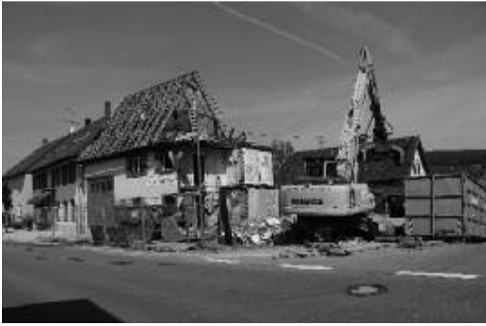
Abbruch des „Haus Weinmann“ an der Hauptstraße in Langenenslingen
