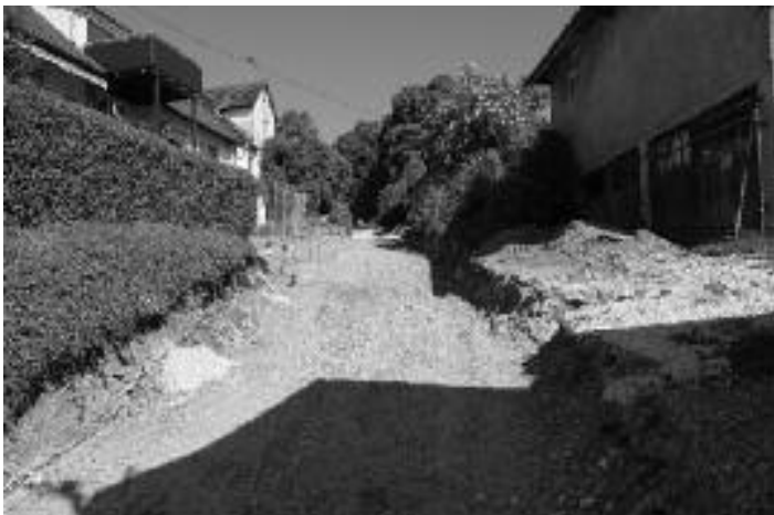
Ausbauarbeiten an der „Steige“ in Friedingen
