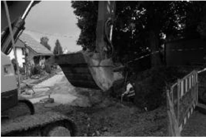
Bauarbeiten an der „Bitzstraße“ in Friedingen
