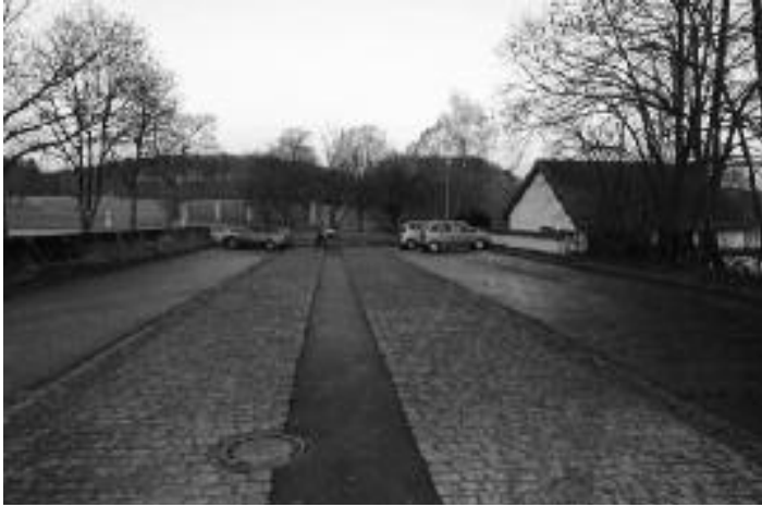
Verbesserung der Zufahrt zum Friedhof in Dürrenwaldstetten
