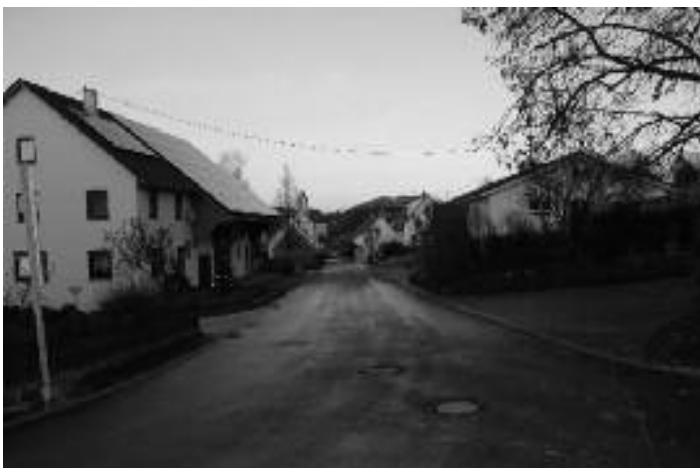
Fertigstellung der „Bitzstraße“ in Friedingen
