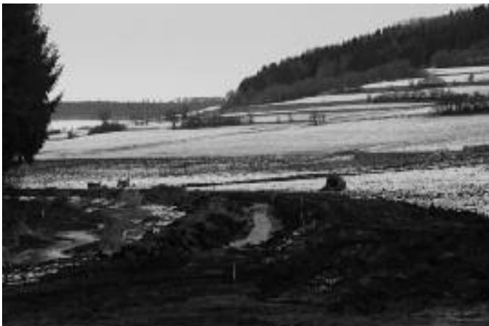
Abschlussarbeiten am Altbach in Andelfingen
