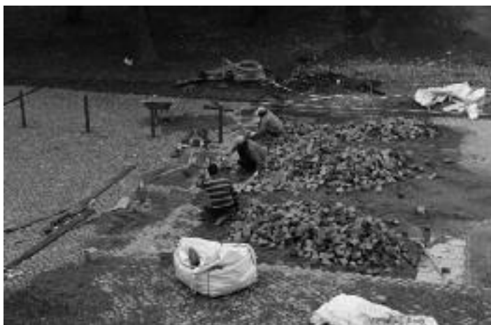
Die Pflasterarbeiten sind schon ordentlich vorangeschritten.
