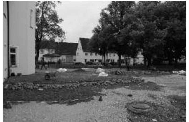
Es ist noch manches Pflaster zu verlegen, bis dieser Bereich am Rathausplatz befestigt ist.
