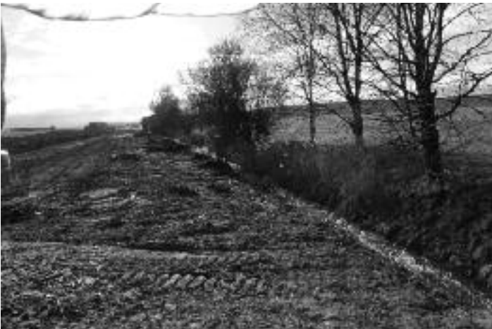
Noch läuft der Altbach im bisher betonierten Bett.
