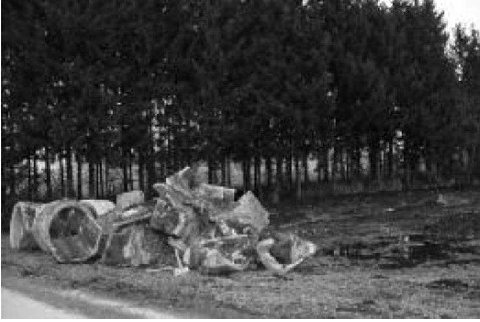
Die alten Betonschalen wurden aus dem Altbachbett herausgenommen.
