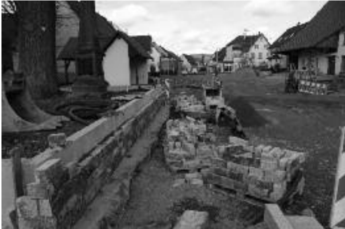
Die notwendige Stützmauer bei der Schleppstufenanlage beim Rathaus in Langenenslingen wird wieder mit den alten Steinen verkleidet.
