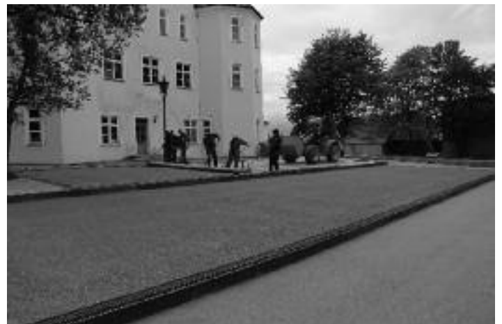
Die Schleppstufenanlage beim Rathaus Langenenslingen wird eingesandet
