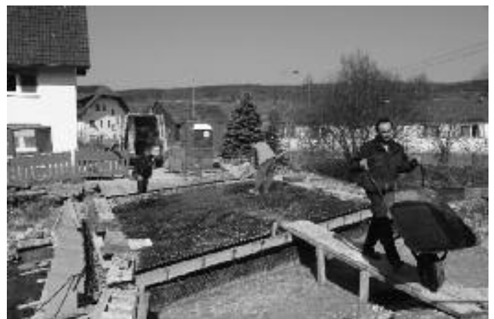
Die Abdichtung wird auf die neue Brücke an der Traubengasse in Langenenslingen aufgebracht.
