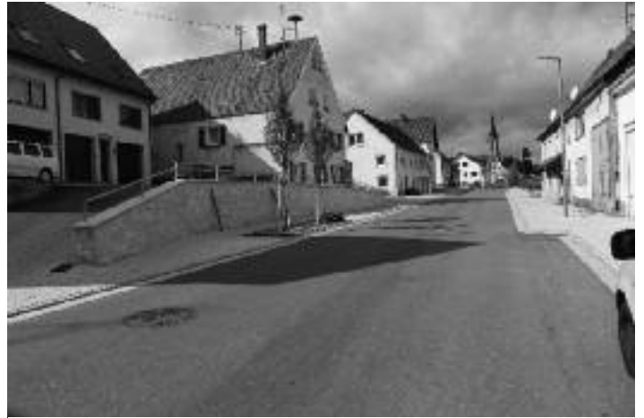
Die alte Betonmauer haben wir mit Kalksteinen verkleidet.
