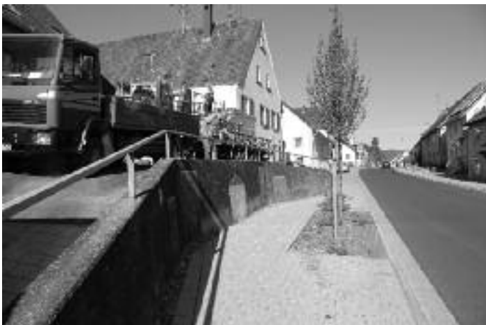
Die Stützmauer an der Hauptstraße in Langenenslingen - wie sie bisher war.
