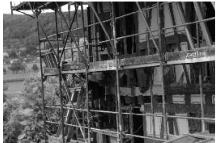
Die Sanierungsarbeiten am Fachwerk des Mauritiushauses in Langenenslingen.
