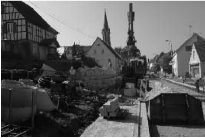
Beim Ausbau der Ortsdurchfahrt in Langenenslingen konnten Haltebuchten angelegt werden.
