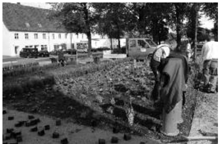
Die Schleppstufenanlage vor dem Rathaus in Langenenslingen wird bepflanzt.
