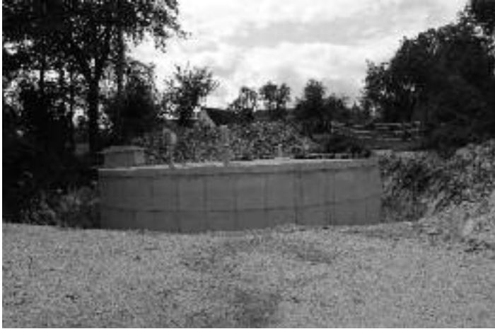
Der neue Löschwasserbehälter in Ittenhausen.
