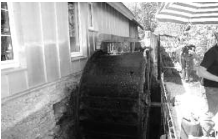
Wieder in Betrieb ist das Mühlrad an der „Langwatte“ beim Sandhof in Langenenslingen.
