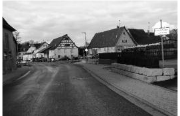
Blick auf den neuen Einmündungsbereich der Schattenweiler Straße in die Hauptstraße in Langenenslingen mit Überquerungshilfe.
