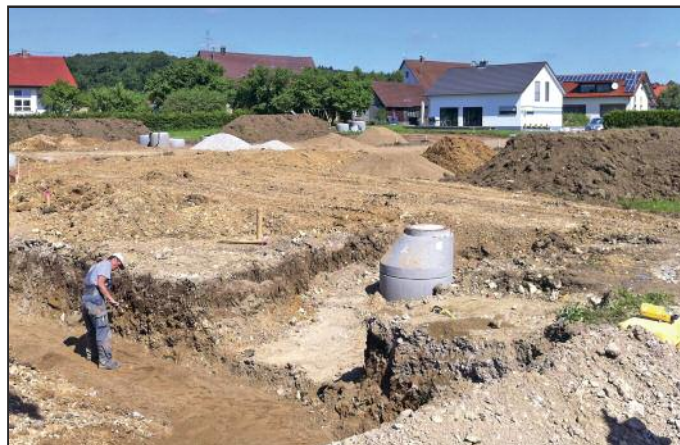
Tiefbauarbeiten zur Erweiterung des Baugebiets „Herdwegäcker“ in Wilflingen
