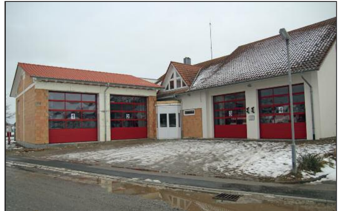
Der Rohbau der neuen Fahrzeughalle beim Feuerwehrgerätehaus Langenenslingen ist fertig.
