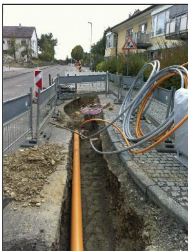
Gasleitung sowie verschiedene Leerrohre zur späteren Breitbanderschließung vor dem Haus für Senioren in Langenenslingen
