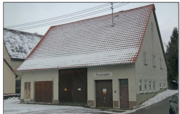
Rechtzeitig vor dem Wintereinbruch wurde die südliche Dachhälfte des Feuerwehrgerätehauses Billafingen erneuert
