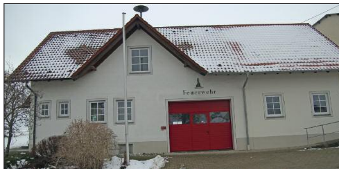
Das neue Sektionaltor inklusive Schlupftür an der Feuerwehrgarage Emerfeld
