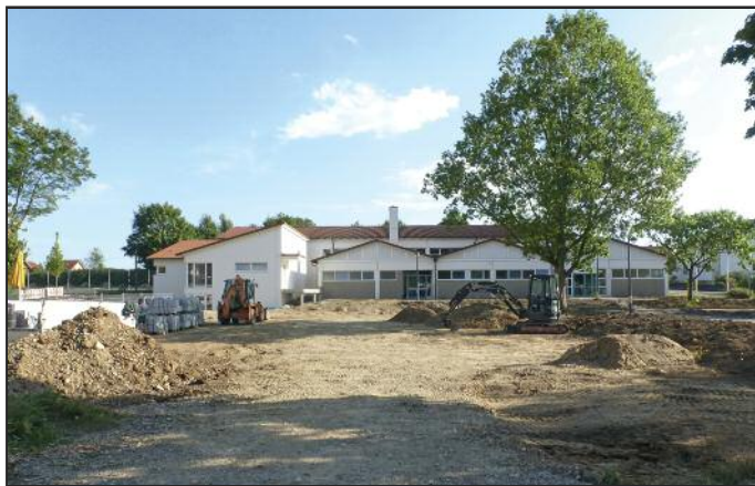
Vor der Turn- und Festhalle Langenenslingen wird ein weiterer Parkplatz angelegt
