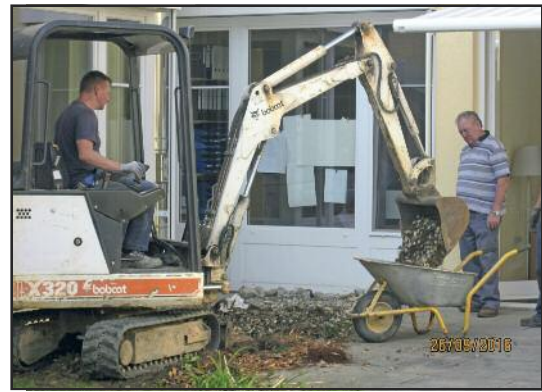
Bei der Gartengestaltung war auch ein Bagger neben der Handarbeit unseres Hausmeisters notwendig um die Bewegungsgeräte aufzustellen und einen Apfelbaum zu pflanzen
