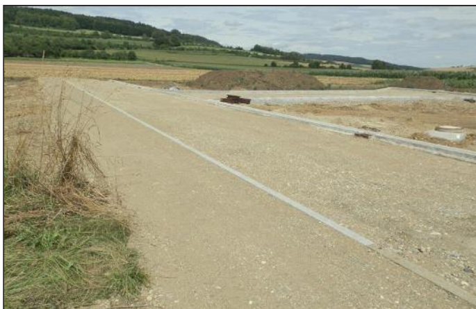
Abgeschlossene Tiefbauarbeiten zur Baugebieterschließung im Baugebiet „Strangeläcker“ in Andelfingen
