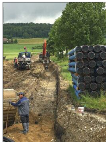
Tiefbauarbeiten zur Erneuerung der Druck- und Falleitung vom Hochbehälter „Berg“ bis zum Ortsnetz Langenenslingen
