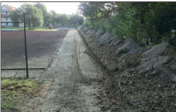
Bauarbeiten zur Erneuerung der südlichen Umfassungsmauer des Hartplatzes
