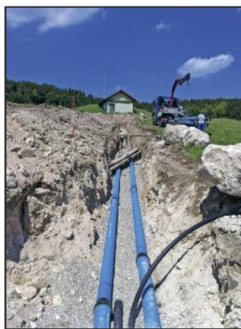
Große Steine mussten bei der Verlegung der neuen Druck- und Falleitung unmittelbar vor dem Hochbehälter „Berg“ beseitigt werden
