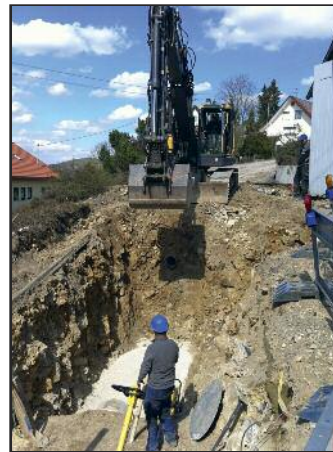
Schwierige Tiefbauarbeiten im Zuge der Erneuerung des Hesenbergs in Friedingen
