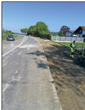
Der neue Geh- und Radweg in Andelfingen entsteht entlang der L277
