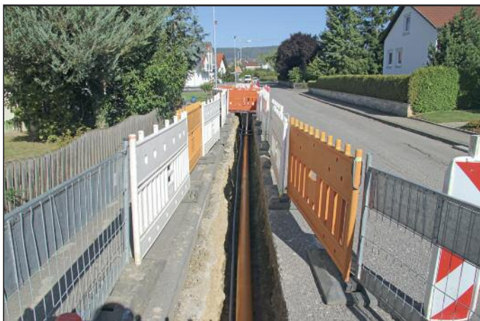
Neu verlegte Gasleitung inklusive Breitbandleerrohre im Bereich der Holzgasse in Langenenslingen
