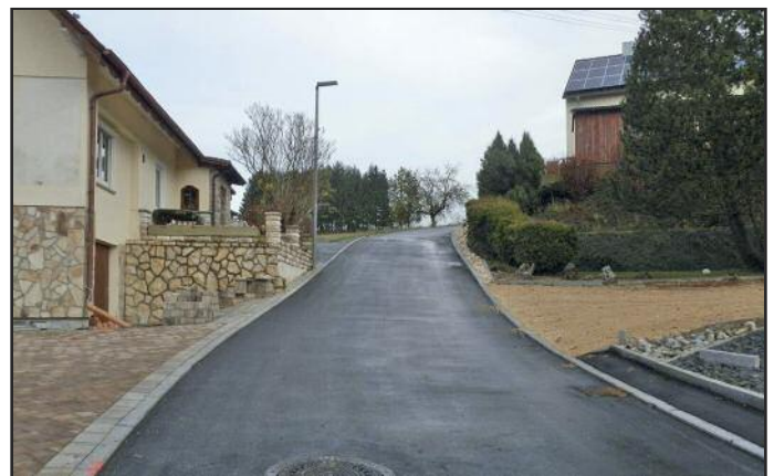
Komplett eingebauter Asphaltbelag im Bereich des oberen Hesenbergs
