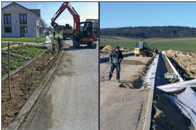
Verlegung von Breitbandleerrohren in der Enhofer Straße in Wilflingen
