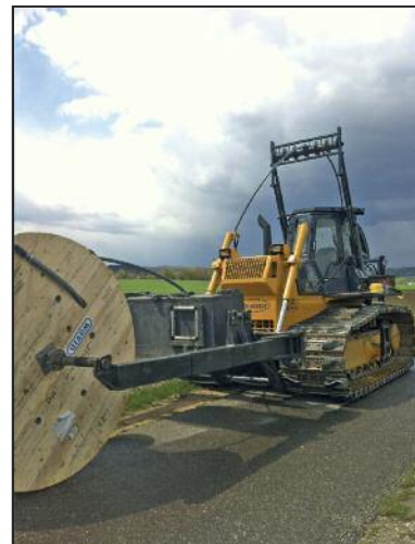
Einpflügen der Breitbandleerrohre zur Verbindung der Ortsteile Friedingen und Andelfingen
