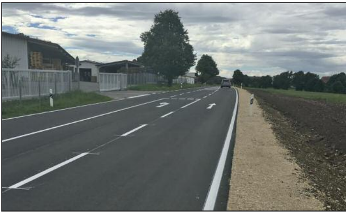
Die Linksabbiegerspur ist fertiggestellt
