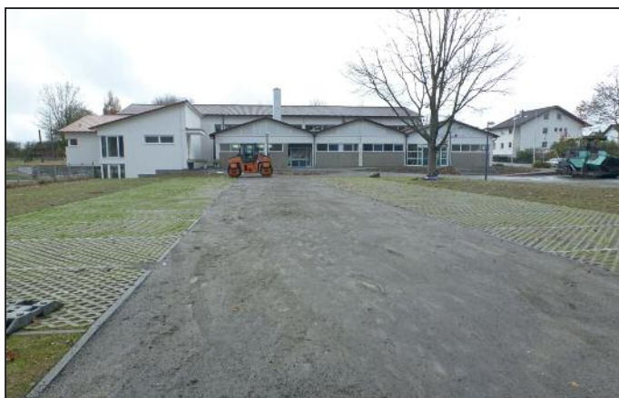
Der neue Parkplatz an der Turn- und Festhalle in Langenenslingen ist fertiggestellt
