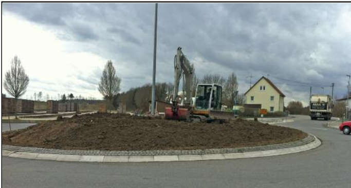
Das Auftragen von neuem Humus war bei der Umgestaltung des Kreisels Andelfingen erforderlich
