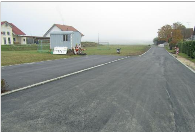
Der Zugangsbereich sowie der Parkplatz am Friedhof Andelfingen wurden asphaltiert
